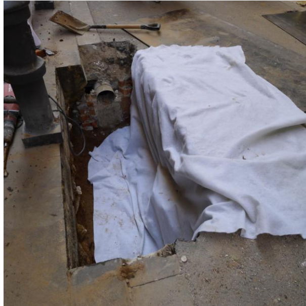
Fig. 2.- Detall del procés de cobriment amb tela geotèxtil de les estructures documentades a E17.
