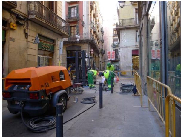
Fig. 2.- Detall del procés de col·locació dels nous embornals.
